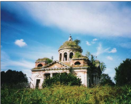
Троицкая церковь. Восточный фасад
