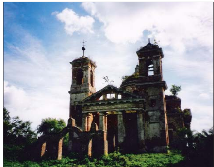
Троицкая церковь. Западный фасад
