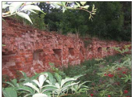
Руины главного дома
