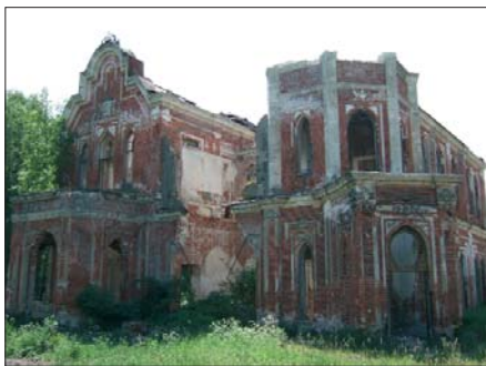
Главный дом. Восточный фасад
